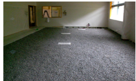
事務所に(施工写真)
