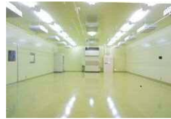
クラス1,000のクリーンルーム
