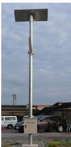
MACK LIGHT (街路灯) 太陽光発電システムで電源不要。緊急時の照明、電源として活躍します！
