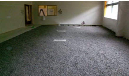
事務所に(施工写真)
