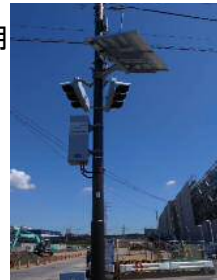
・全国初の太陽光発電による信号機
